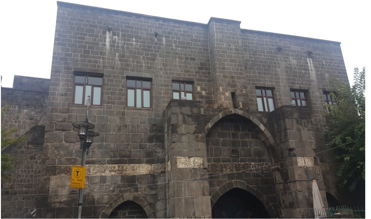
Diyarbakır Darkapı Mervani Camii
